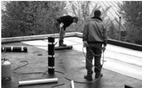
Flachdachabdichtung auf dem neuen Lager
